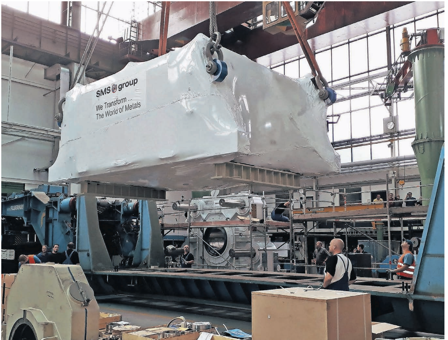
Getriebelieferung: Der Schwerlastverkehr zwischen Hamburg und Nordrhein-Westfalen wird präzise vorbereitet, aufwendig genehmigt und aufmerksam von einer Projektgruppe begleitet.
