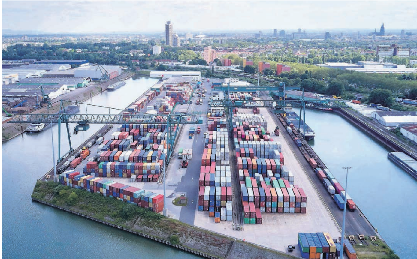
CTS Container-Terminal im Hafen Köln-Niehl: Leistungsfähige Anbindung an den Hafen Hamburg
